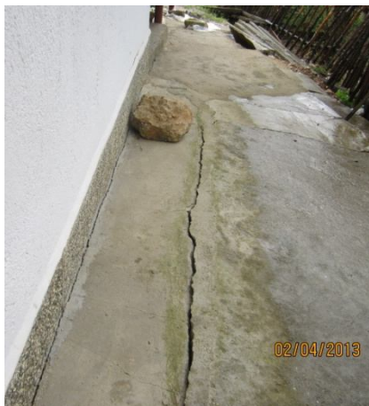
Деформирана външна бетонова площадка и плочник
