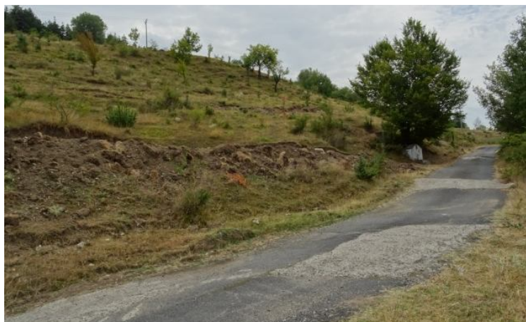
Аварийно засипване с бетон за изглаждане на неравностите
