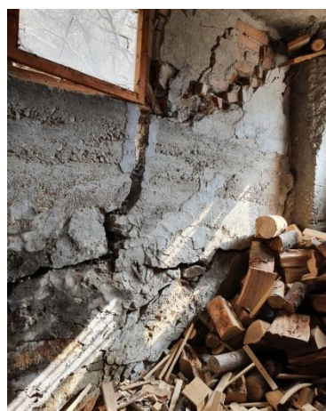
Значими деформации по пристройката на СО1
