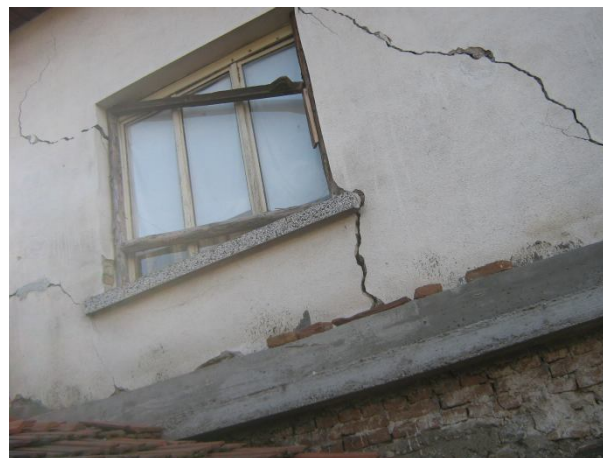
Деформирана сграда с изпълнено конструктивно укрепване
