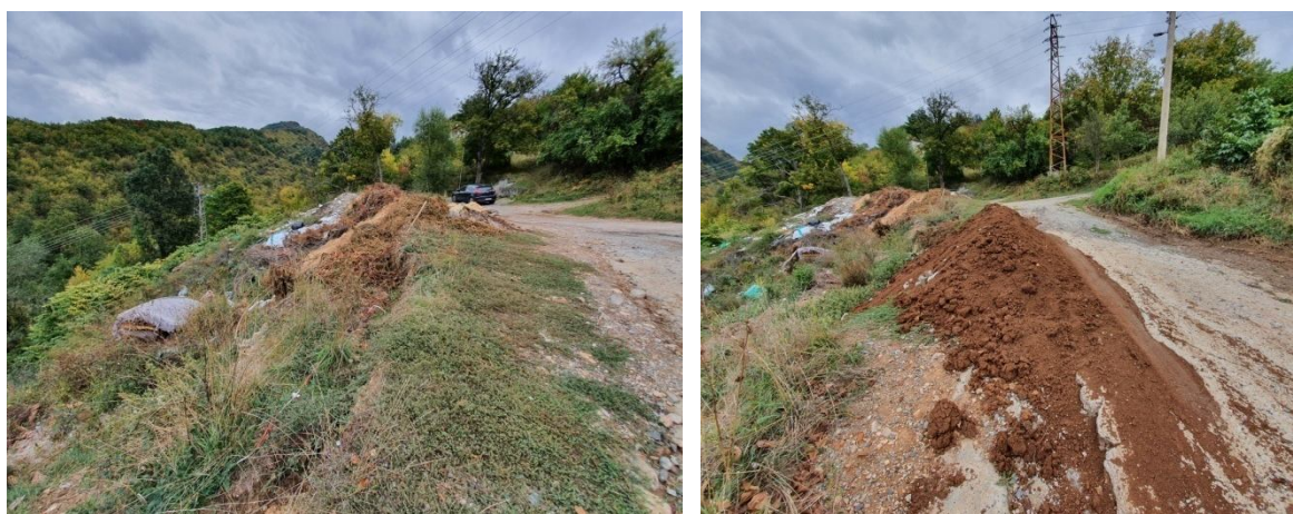
Изглед на участъка откъм ул. „Виноград” с насипи от строителни отпадъци
