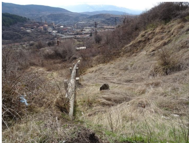
Довеждащ главен водопровод за гр. Бобов дол
