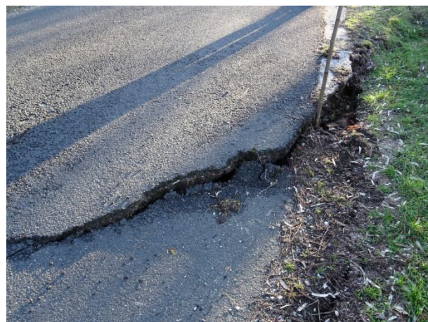
Свлачищни деформации по асфалтовата настилка
