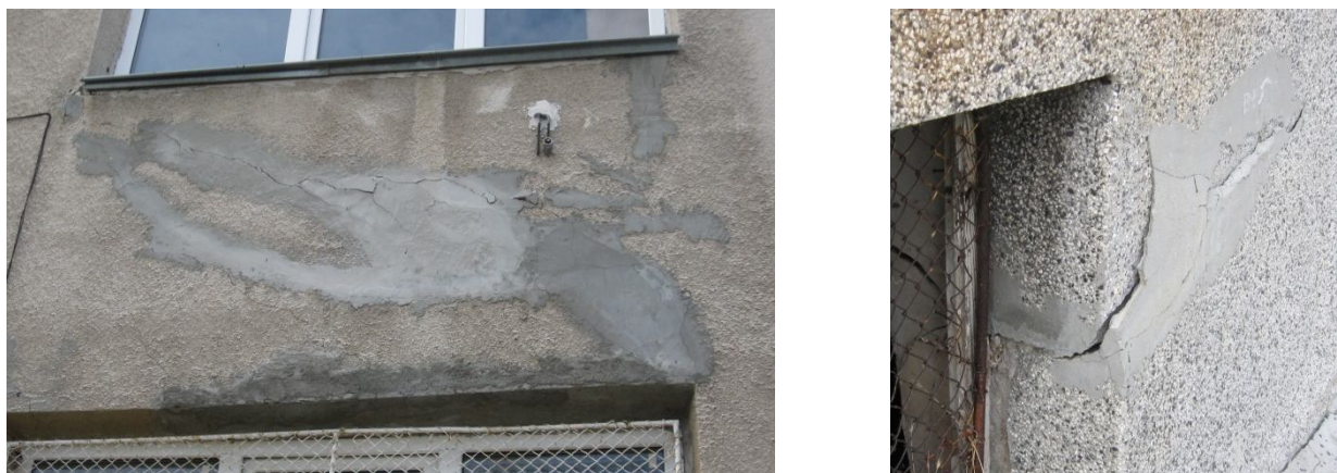
Подуване и разместване в отделни зони по фасадата /2016 г./
