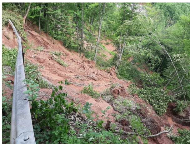
Свлечени земни маси под формата на кален поток
