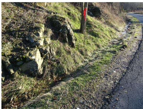
Открита земна канавка
