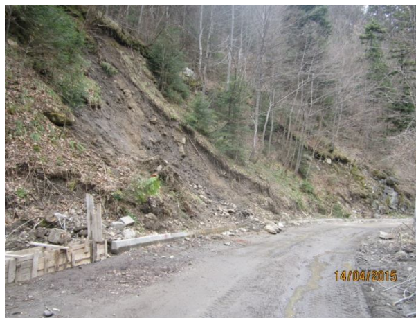
Неустойчив откос в резултат на срутищно-свлачищни процеси при km 4 +900
