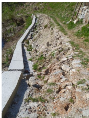
Разрушена каменно-зидана подпорна стена /2015 г./
