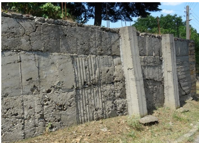
Допълнително укрепване чрез стоманобетонни колони
