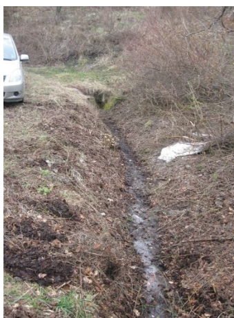
Дрениране на води в отводнителната канавка
