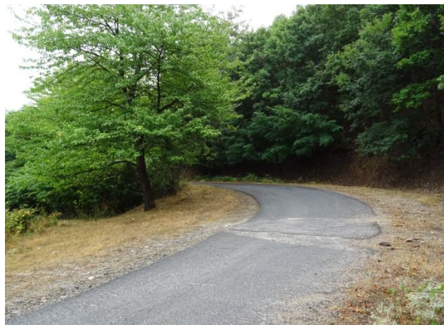
Заличена деформация с преасфалтиране
