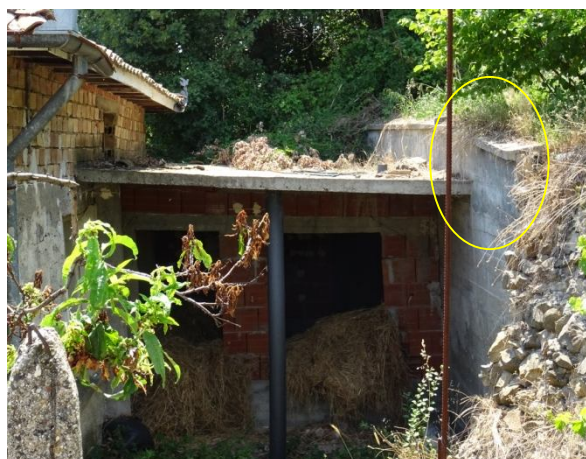
Наклонен ръб на подпорна стена
