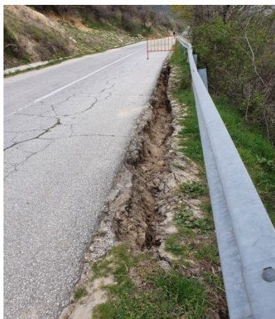
Отстъп и деформации на пътното платно при km 40 +910 /април, 2020 г./
