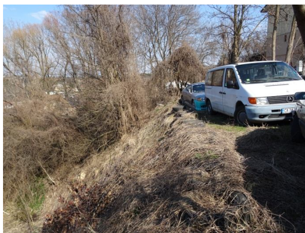
Състояние на свлачищния откос
