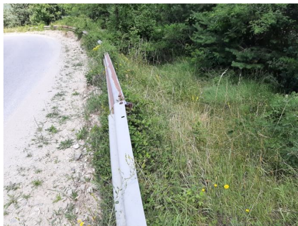
Затревен и залесен въздушен откос
