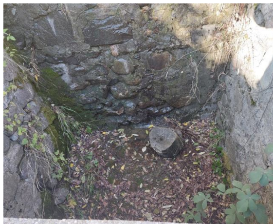
Изградена шахта /вток на водосток/
