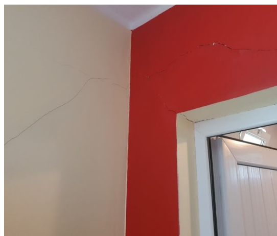
Напуквания по стените на сградата в УПИ VI
