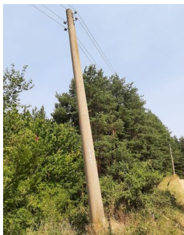
Наклонен ел. стълб
