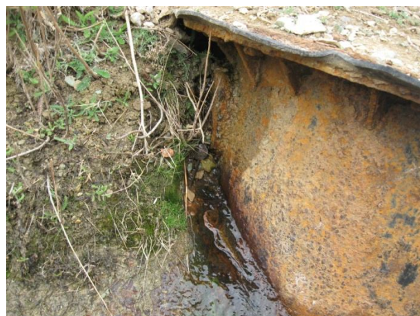
Шахта-въздушник № 53 с постоянен теч на вода /октомври, 2016 г./
