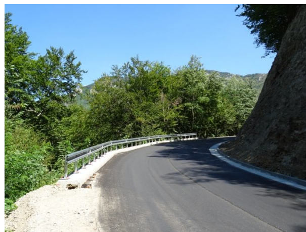
Рехабилитиран и укрепен свлачищен участък на път III-861 при km 3 +500
