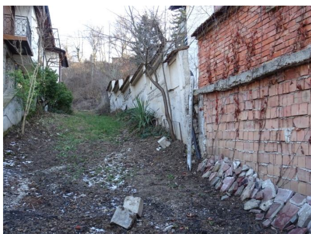
Деформации по ограден зид и стълбище
