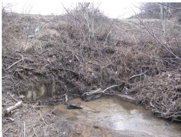
Замочуряване пред входа на водостока, поради затлачване /2015 г./
