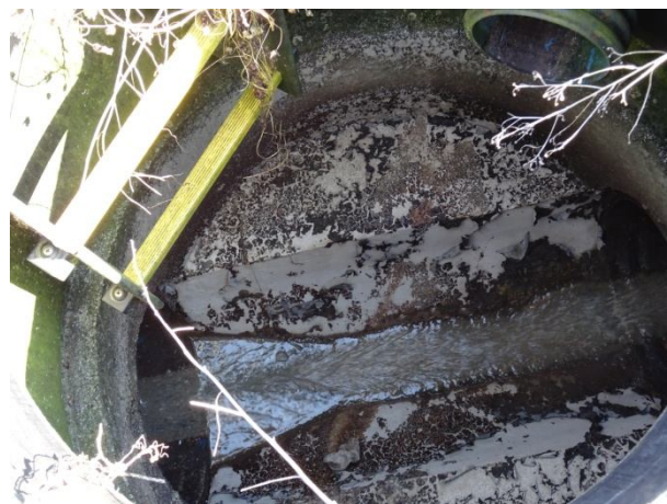
Шахта от канализационния колектор без капак
