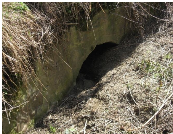
Проявени деформации на пропадане и затлачване на водостока /2015 г./
