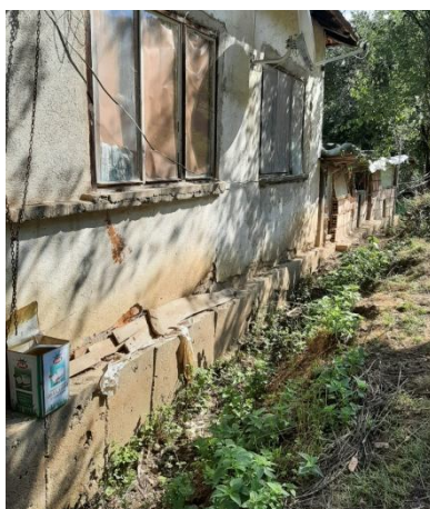
Бетонов пояс при южната фасада на сградата
