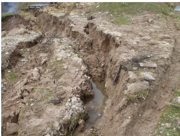
Главен свлачищен откос
