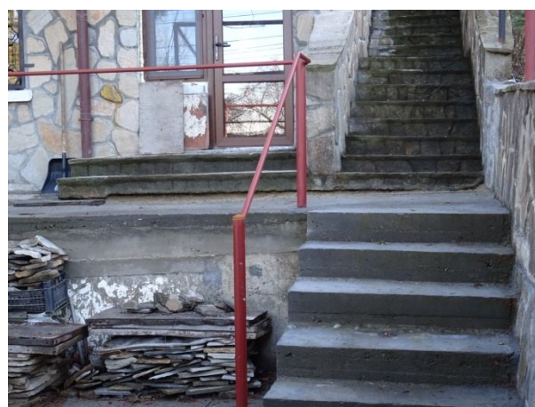
Деформации по ограден зид и стълбище
