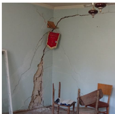
Деформации по сградата на кметството
