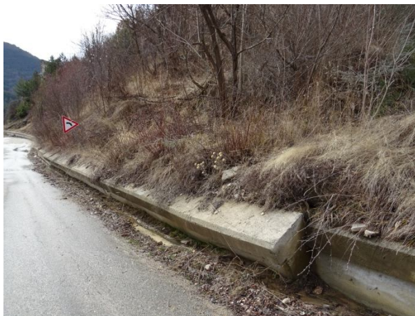
Разрушена ниска стена на пътното платно /02.2021 г./
