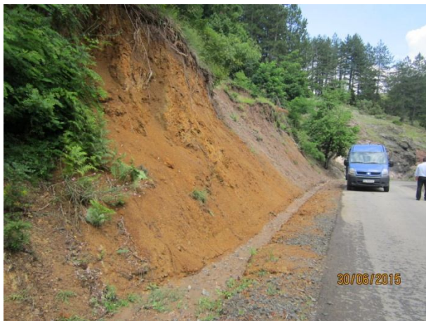
Изпълнени аварийно почистване на пътното платно и отводнителна канавка
