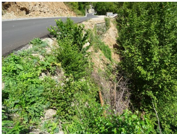
Аварийно възстановяване на пътното платно при km 18 +900
