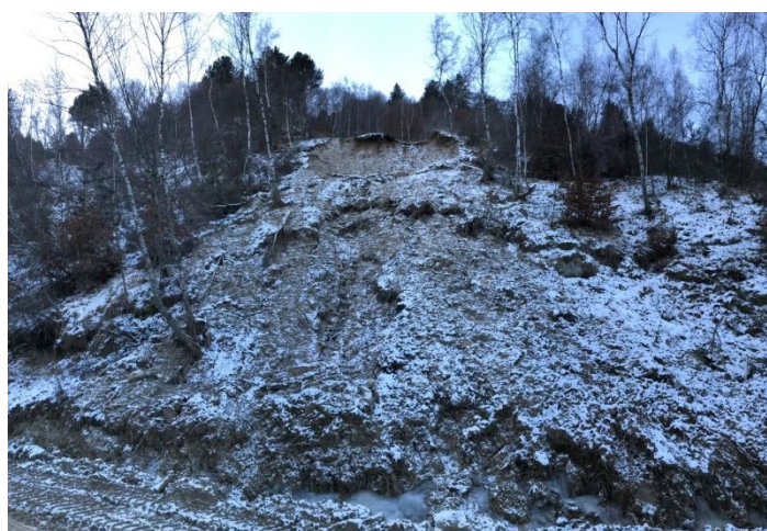
Общ изглед на свлачищния участък
