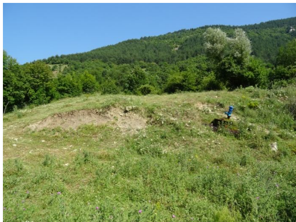
Главен свлачищен откос при шахта-въздушник № 53 /юли, 2020 г./
