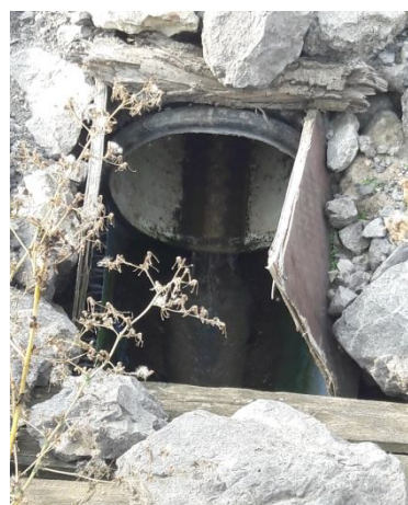
Заустване в главния колектор
