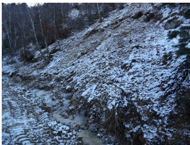
Разчистени земни маси в базиса на свличане
