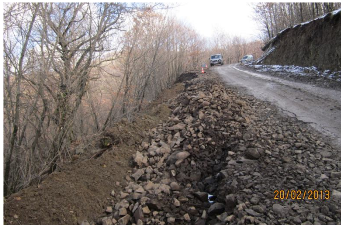
Извършени аварийни СМР и дрениране на води в петата на ската /20.02.2013 г./
