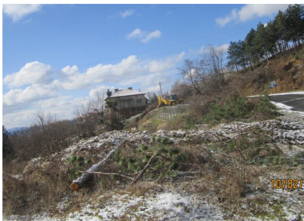
Откос на свличане, свлачищен клин и депото за свлечените маси
