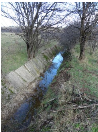
Облицован напоителен канал, преминаващ над свлачищния участък
