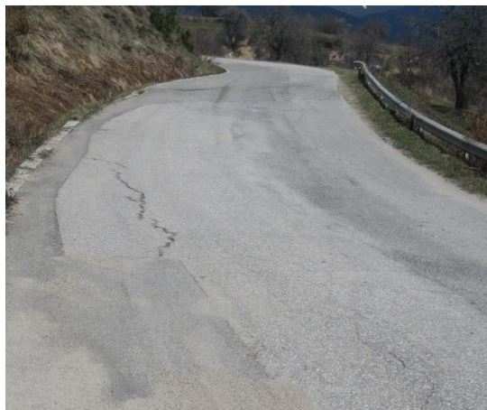
Проявени деформации на пропадане и затлачване на водостока /2015 г./
