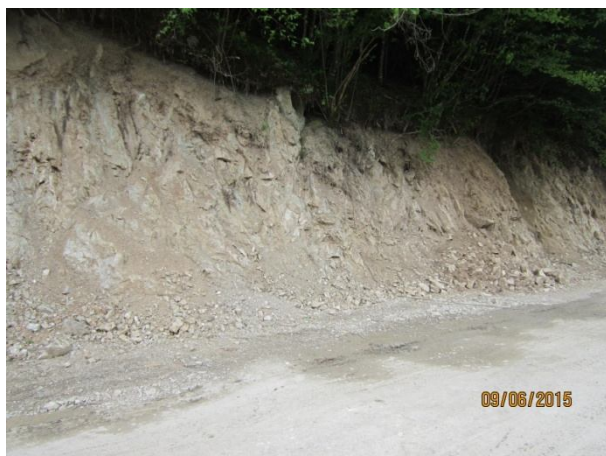
Изглед към засегнатия участък – преоткосиране и насипване /юни, 2015 г./
