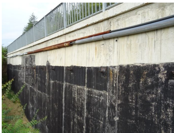
Изградена укрепителна стоманобетонoва анкерирана подпорна стена
