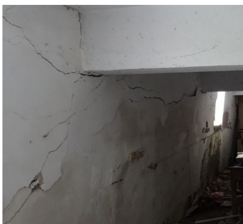
Деформации по стените в работилницата на ниво -1
