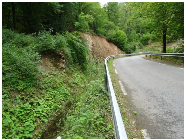
Затлачена канавка, която не е облицована по цялата дължина
