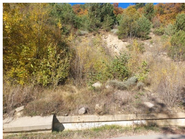
Компрометирана ниска джоб стена на пътното платно откъм ската
