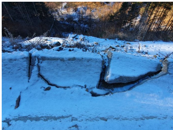
Разрушена част от облицования пътен окоп
