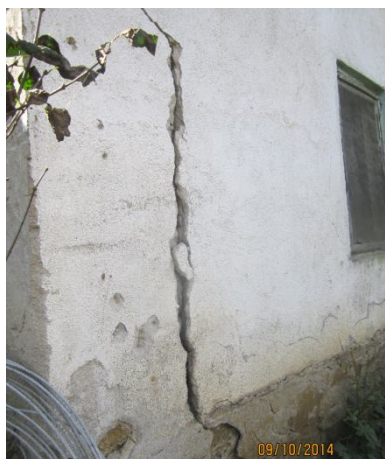
Проявени деформации по северна стена на сградата Деформации по стълбищно тяло /2014 г./
