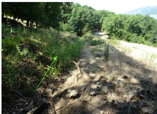
Отводнителна канавка над пътя с местоположение на водостока
