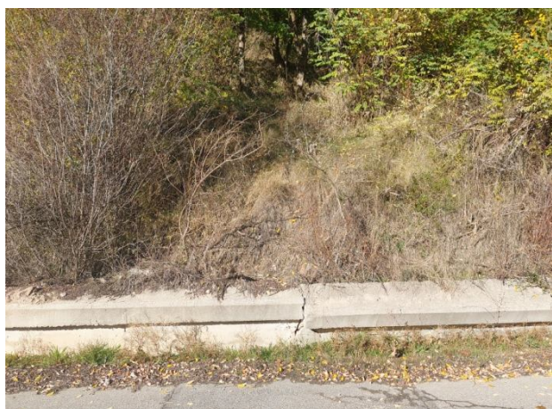
Компрометирана ниска джоб стена на пътното платно откъм ската
