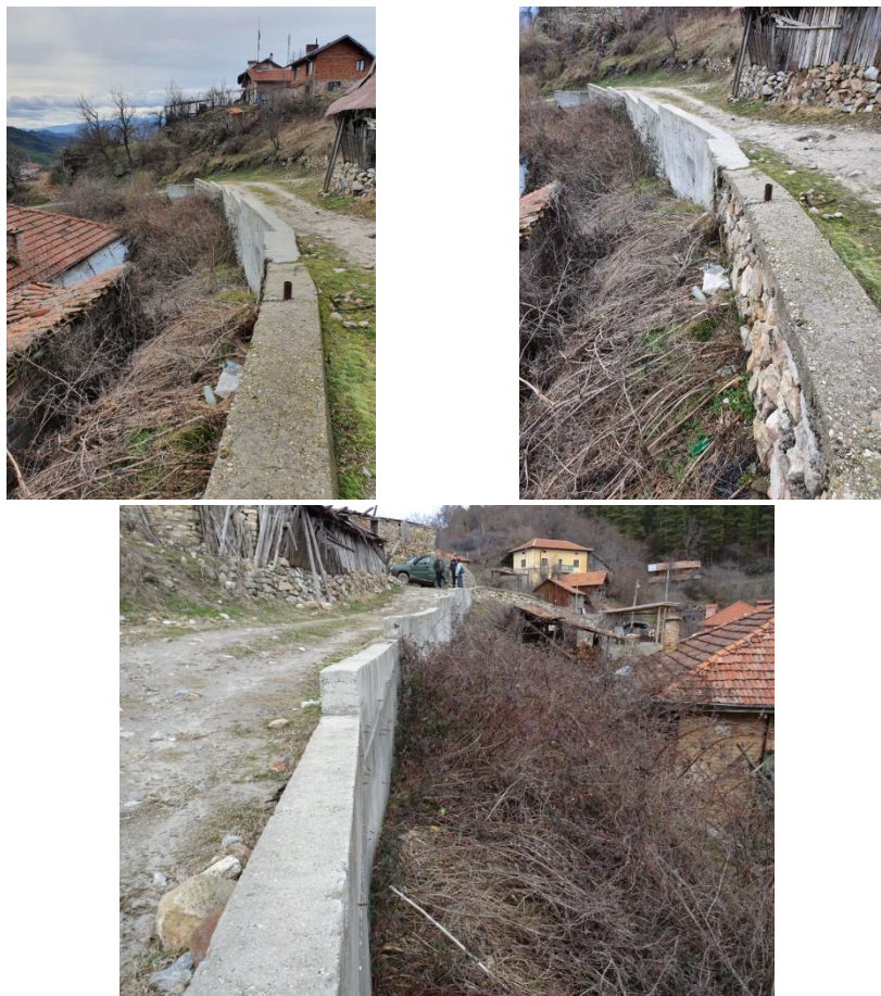
Общ изглед на изградената подпорна стена
