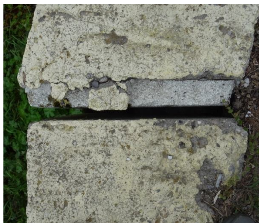
Деформации по укрепителните съоръжения /2020 г./
