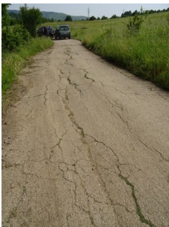
Липса на отводнителна канавка и съществуващ тръбен водосток
