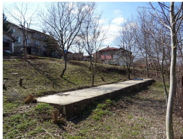
Укрепителна пилотна конструкция с ростверк
