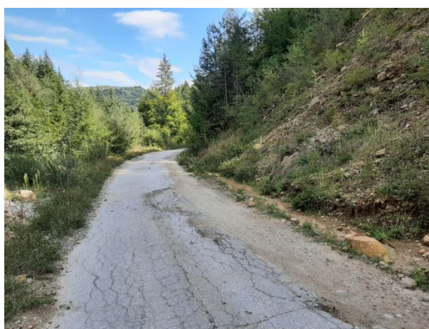
Общ изглед на свлачищния участък и земна отводнителна канавка
