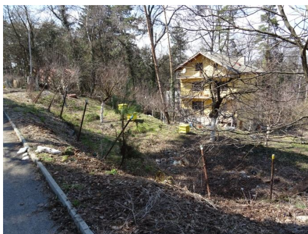
Изглед към свлачищния участък от страната на ул. “Републиканска”
