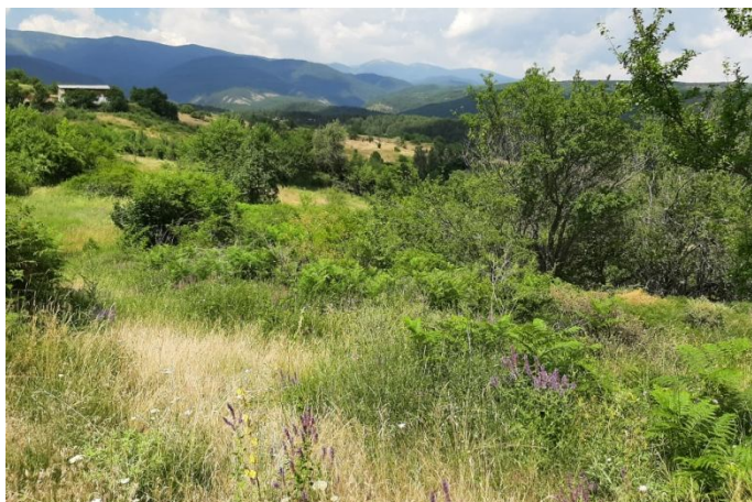
Общ изглед на свлачищното тяло по склона под пътното платно
