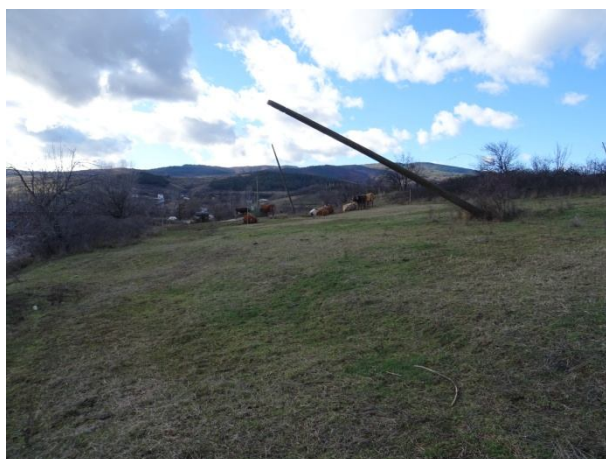
Наклонен ел. стълб
