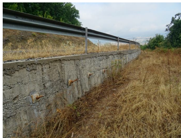
Състояние на анкерираното съоръжение
