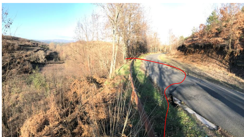
Общ изглед на свлачищния участък
