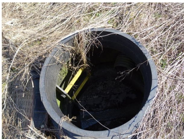
Шахта от канализационния колектор без капак
