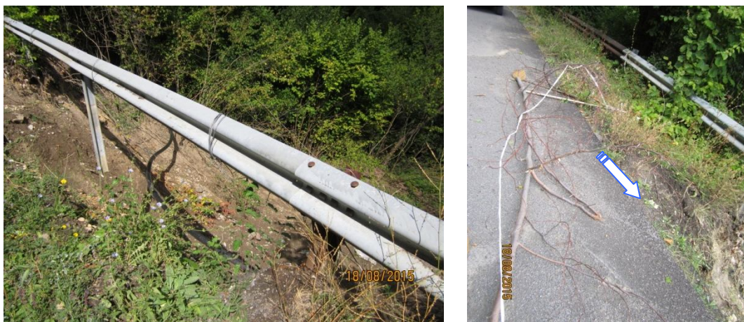
Изглед към оголения циркус и формация се повърхностен отток в обсега на банкета и левия борд
