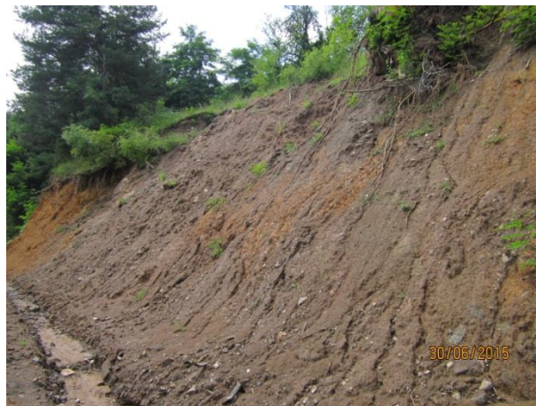
Изпълнени аварийно почистване на пътното платно и отводнителна канавка
