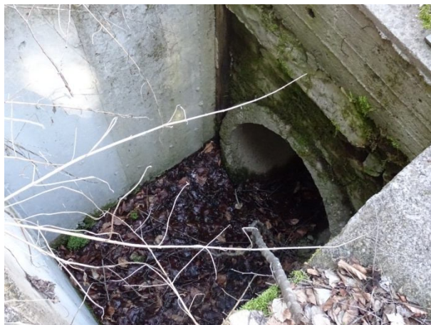
Водосток при km 4 +900
