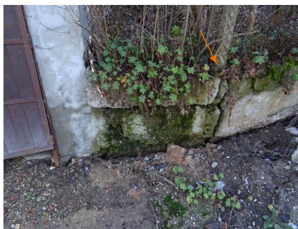
Слягане и подуване между гаража и ел. стълб при № 50
