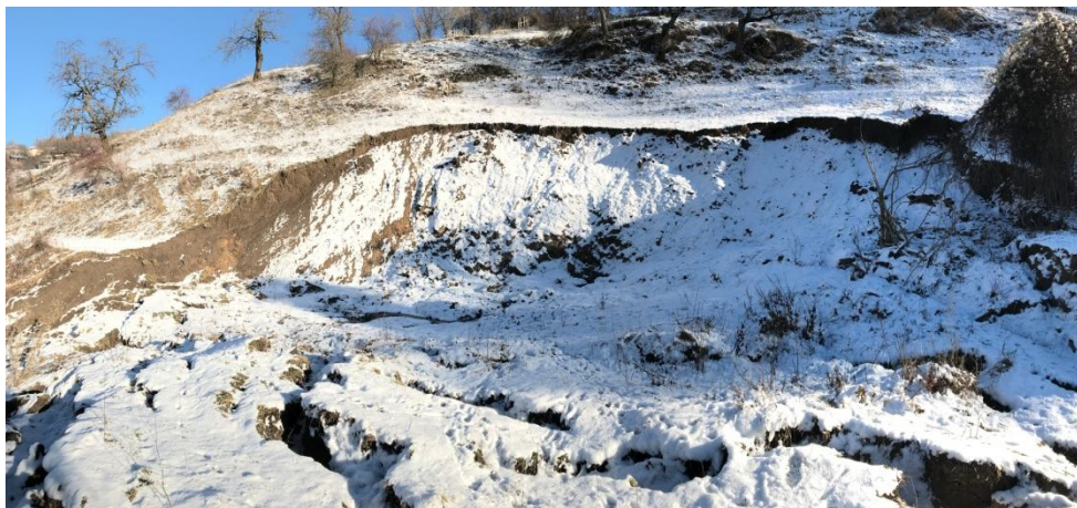
Фронтален изглед към свлачищния участък
