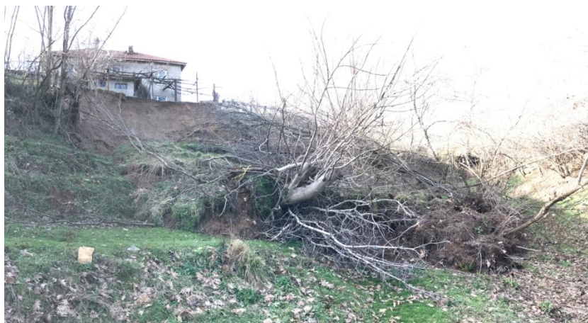
Разструктурени земни маси и оформен свлачищен език
