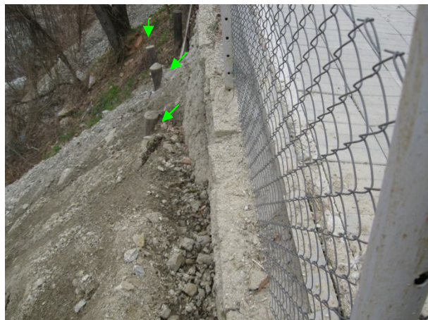
Слягания по тротоар откъм откоса на р. Бистрица с изпълнени дървени пилоти /2015/
