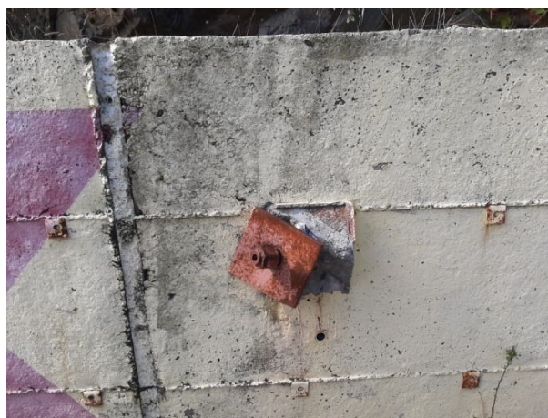
Разрушен анкер
