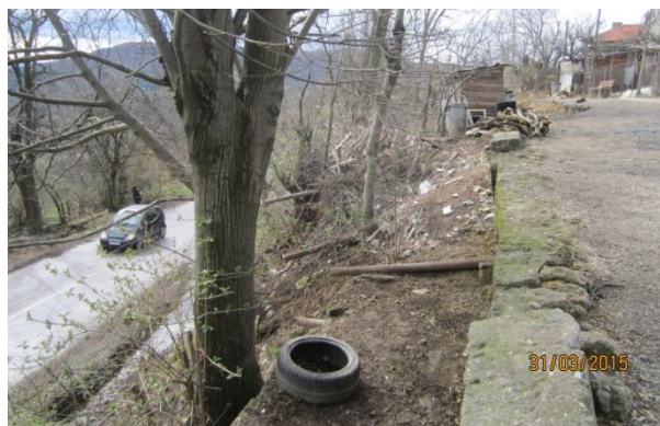
Състояние на откоса и инфраструктурата в близост до свлачищното тяло
