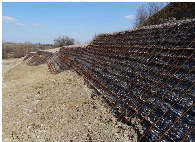
Контрафорсна призма в югоизточния край на свлачищния откос
