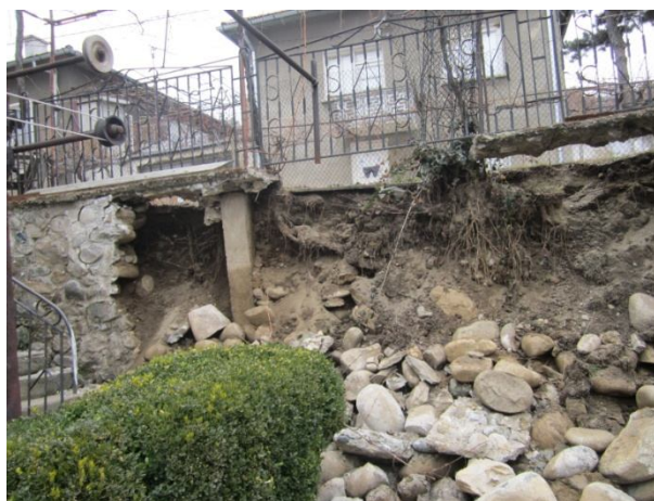
Разрушен подпорен зид /2012 г./
