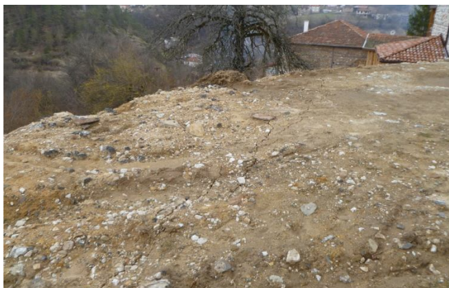
Пукнатина на срязване, проявена южно от свлачищния откос /2015 г./
