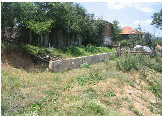
Южна подпорна стена /юли, 2010 г./
