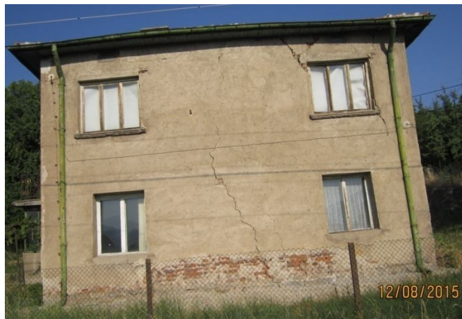
Разрушен участък от подпорната стена /2015 г./ Деформирана жилищна сграда /2015 г./
