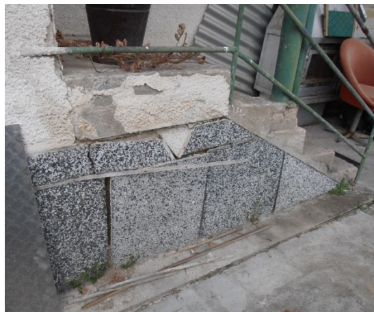
Деформации по външна мазилка и плочници /април, 2015 г./
