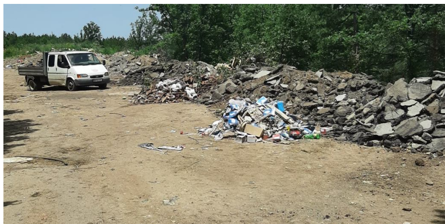
Строителни и битови отпадъци в района на главния свлачищен откос
