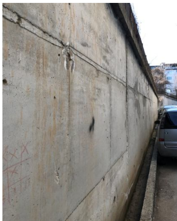
Отводнителен канал по протежението на стената
