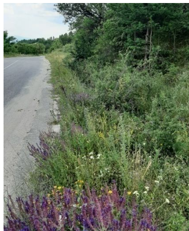
Затлачена и непочистена земна отводнителна канавка
