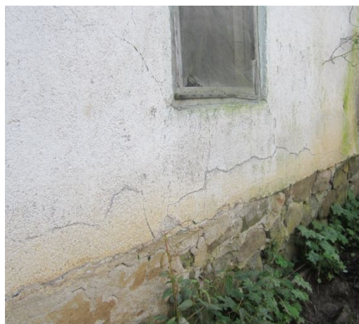
Проявени деформации по северна стена на сградата Деформации по стълбищно тяло /2014 г./
