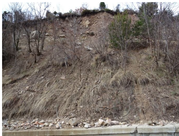
Главен свлачищен откос /02.2021 г./
