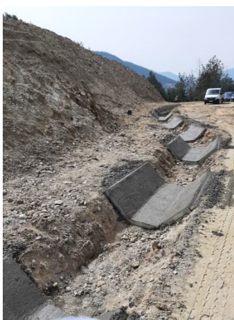
Бетонова канавка в процес на изграждане
