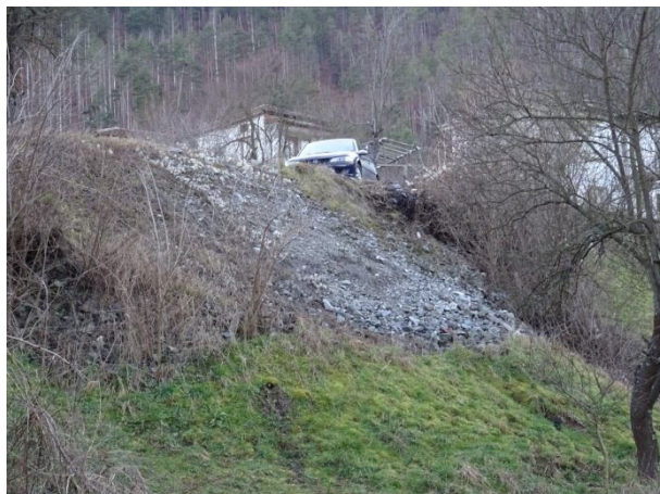
Засипване с трошен камък
