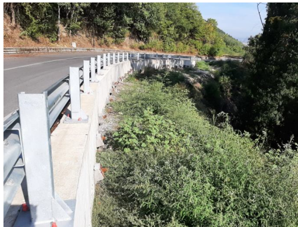
Общ изглед на стоманобетонена подпорна стена
