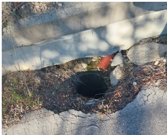
Компрометирана шахта на втока на водосток на пътя
