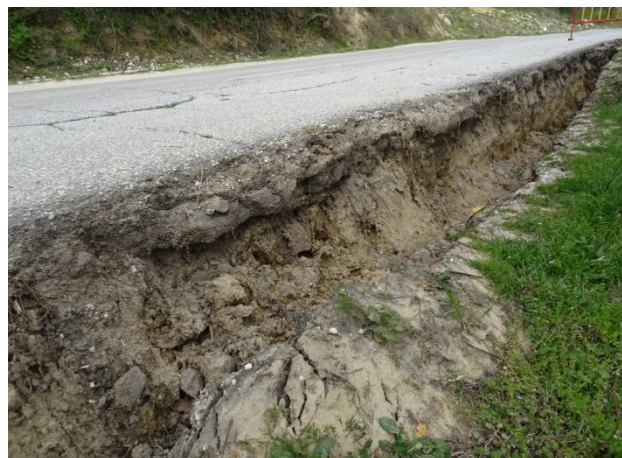
Отстъп и деформации на пътното платно при km 40 +910 /април, 2020 г./
