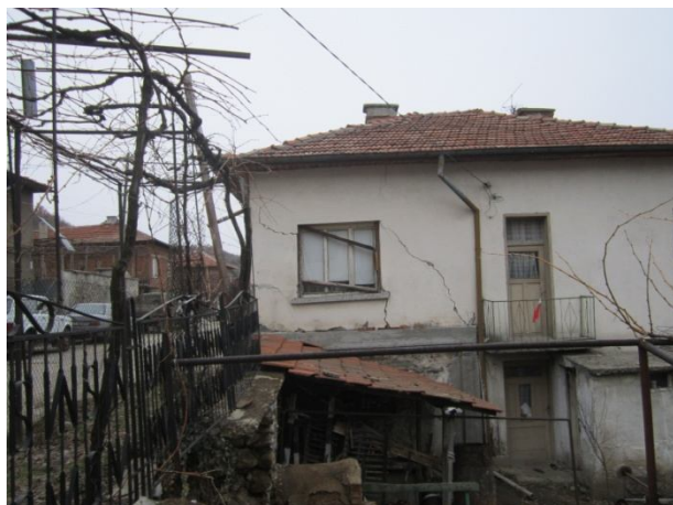
Деформирана сграда с изпълнено конструктивно укрепване
