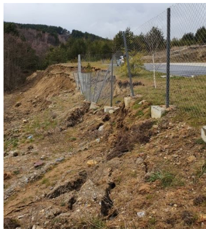
Оголени и разрушени фундаментни блокчета на оградни стълбове
