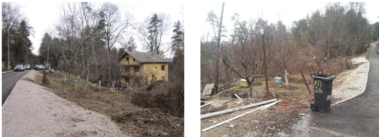
Състояние на ул. "Републиканска" след ремонта /март, 2017 г./
