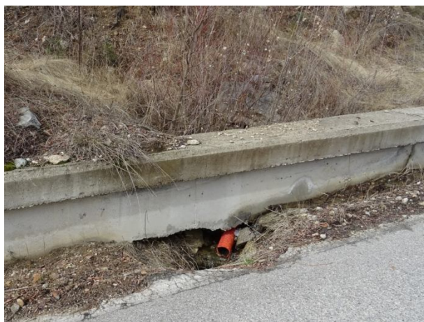
Шахта на втока на водостока /02.2021 г./
