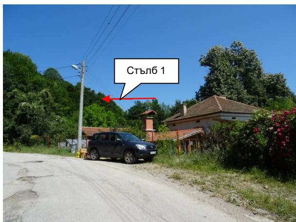
Сменени са три от наклонените при свличането ст.б. ел. стълбове
