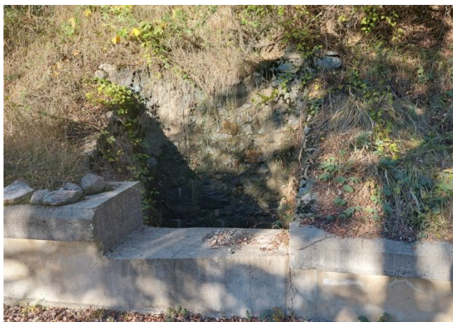
Изградена шахта /вток на водосток/
