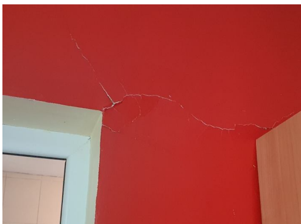
Напуквания по стените на сградата в УПИ VI
