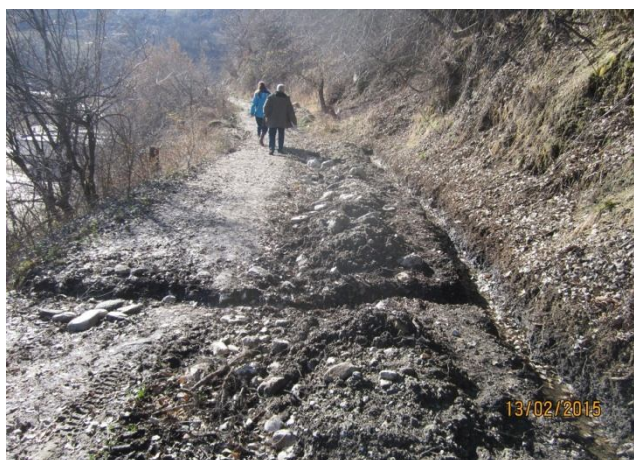
Канавка за отвеждане на повърхностния отток /февруари, 2015 г./
