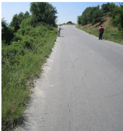
Общ изглед от участъка при североизточния водосток /юли, 2013 г./
