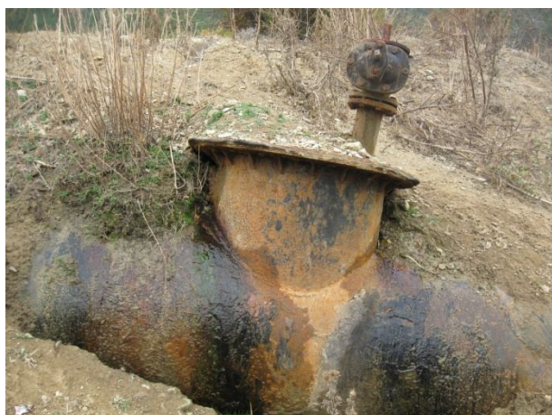
Шахта-въздушник № 53 с постоянен теч на вода /октомври, 2016 г./
