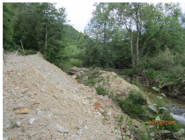
Изглед към засегнатия участък – преоткосиране и насипване /юни, 2015 г./
