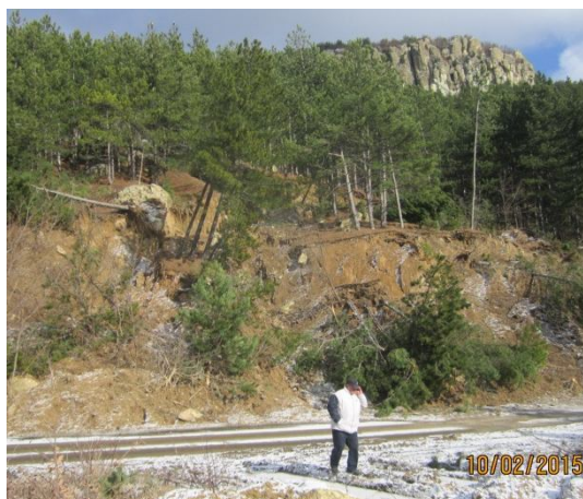
Откос на свличане, свлачищен клин и депото за свлечените маси
