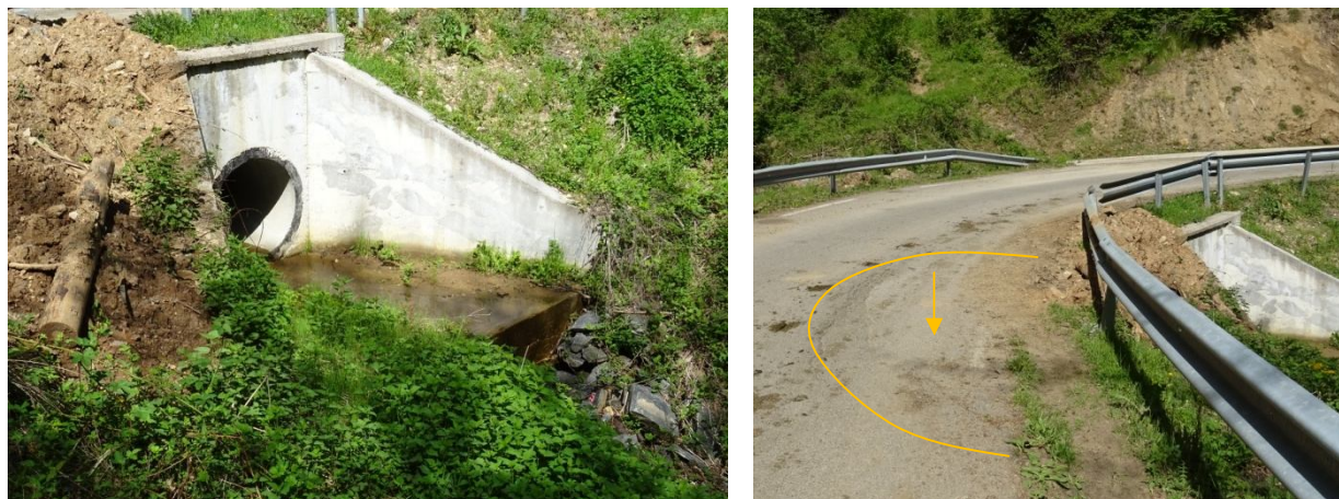
Водосток при югозападния завой /май, 2020 г./
