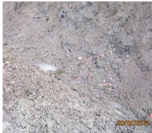
Извършени аварийни СМР и дрениране на води в петата на ската /20.02.2013 г./
