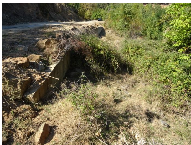
Изглед към свлачищен участък № 1 и компрометираната подпорна стена
