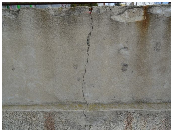
Деформации по бетонова ограда на ОДЗ „Дружба”
