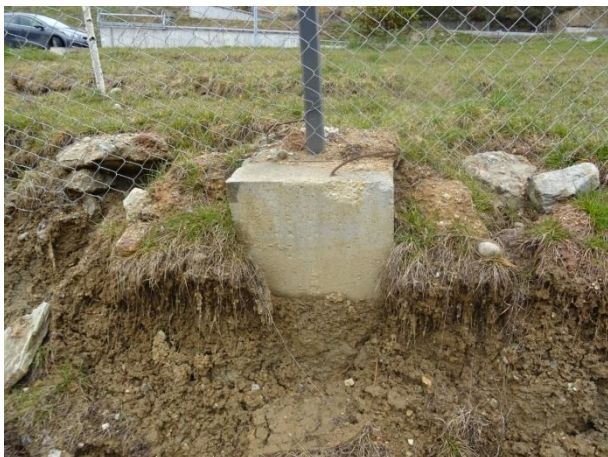
Оголени и разрушени фундаментни блокчета на оградни стълбове
