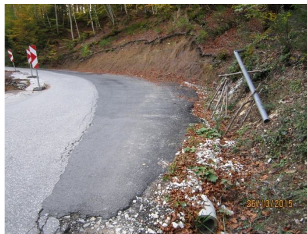
Аварийно преоткосиране за възстановяване на движението /октомври, 2015 г./
