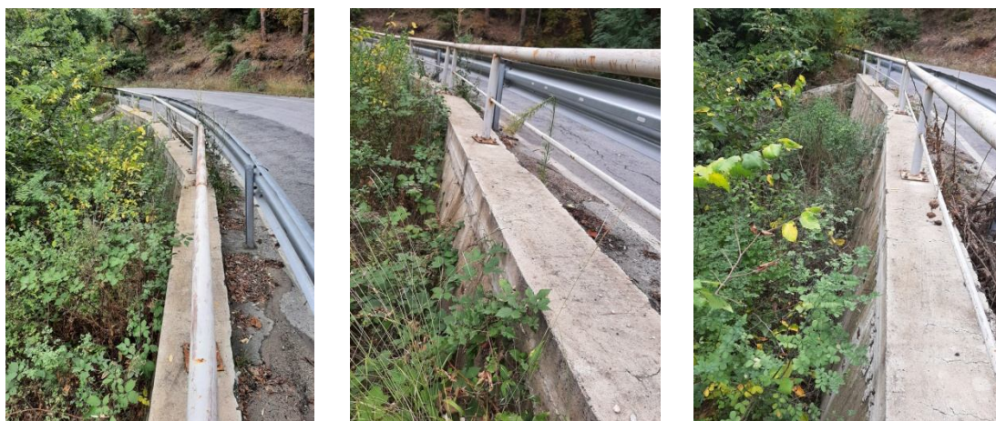
Изградена укрепителна стоманобетонна подпорна стена
