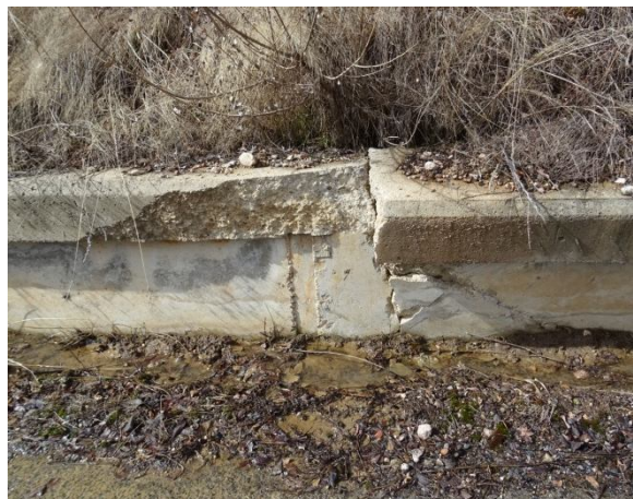
Разрушена ниска стена на пътното платно /02.2021 г./
