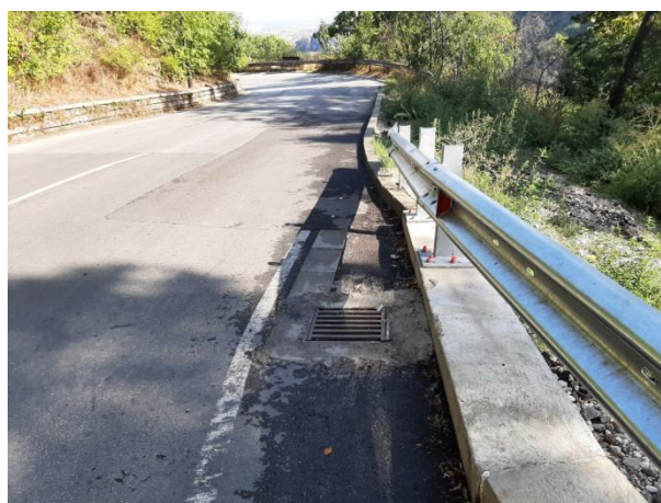
Изградена дъждоприемна решетка
