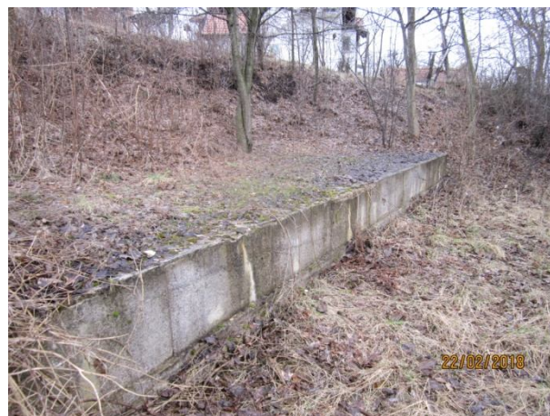
Укрепителна пилотна конструкция с ростверк
