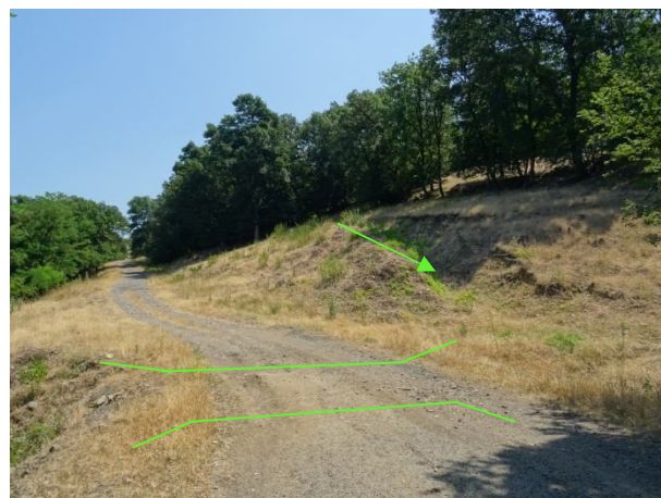
Отводнителна канавка над пътя с местоположение на водостока
