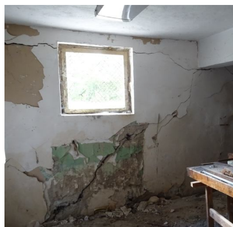
Деформации по стените в работилницата на ниво -1
