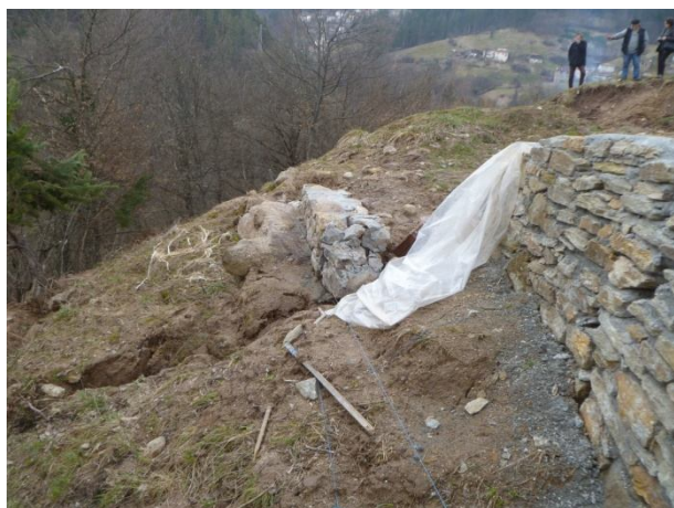
Разрушена оградна подпорна стена /2015 г./
