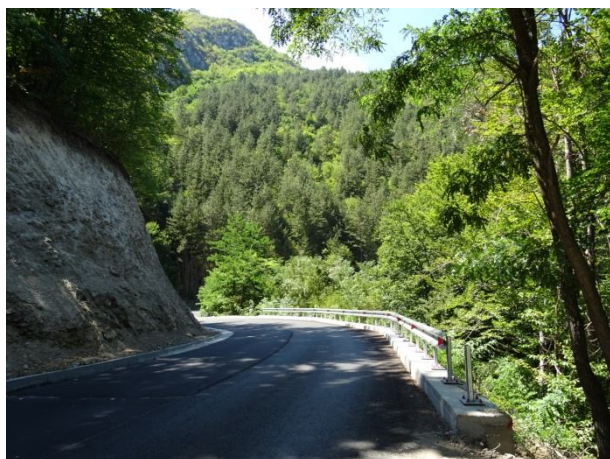
Рехабилитиран и укрепен свлачищен участък на път III-861 при km 3 +500
