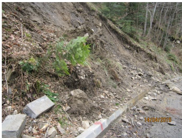
Неустойчив откос в резултат на срутищно-свлачищни процеси при km 4 +900
