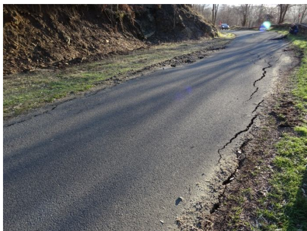
Свлачищни деформации по асфалтовата настилка
