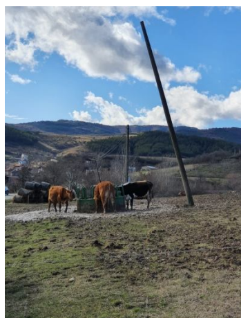
Наклонен ел. стълб в близост до хранилка за добитък
