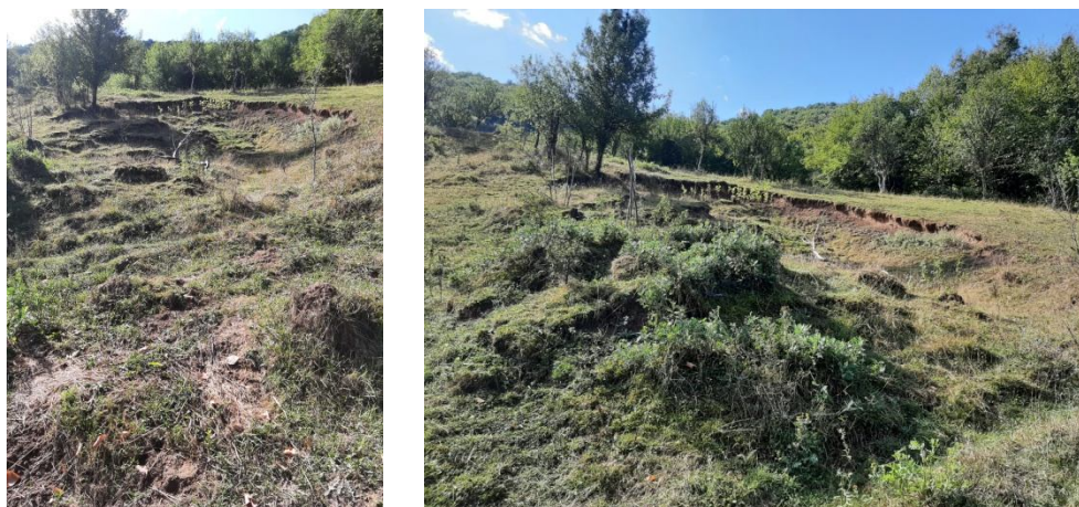
Общ изглед на свлачищния участък
