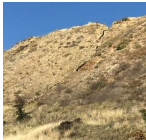
Табан-насипище и оврагообразуване по южния му откос /октомври, 2020 г./
