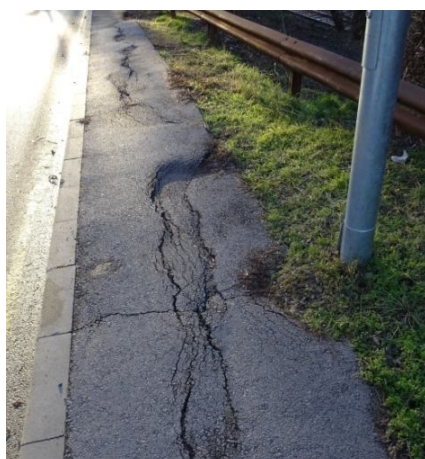
Деформации до пешеходната пътека
