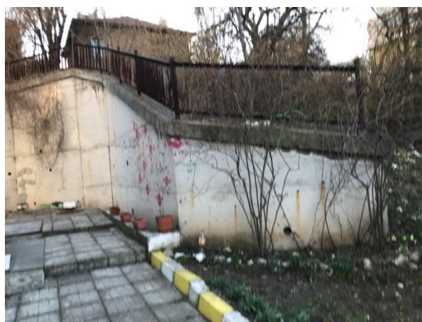
Подпорно съоръжение зад бл. 49
