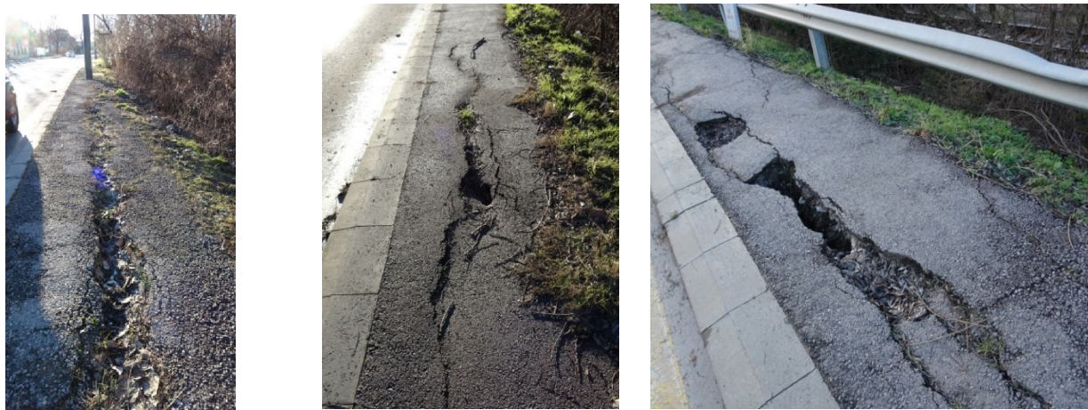
Деформации по тротоара
