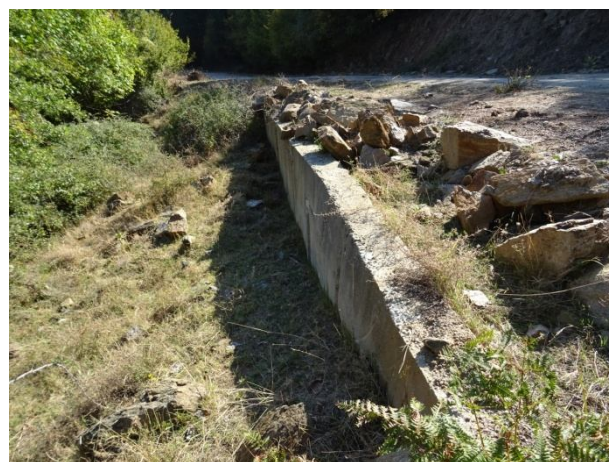
Изглед към свлачищен участък № 1 и компрометираната подпорна стена
