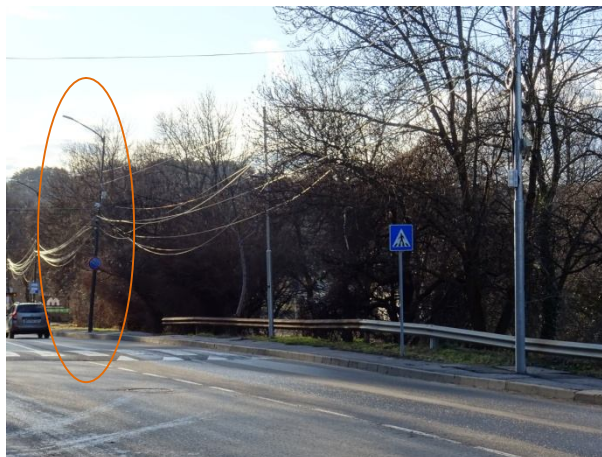
Наклонен ел. стълб
