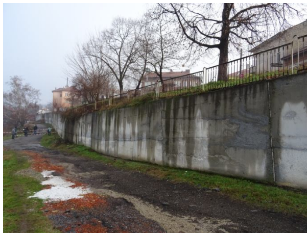
Общ изглед на подпорната стена по ул. „Христо Ботев”
