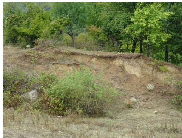
Овлажнен свлачищен откос при шахта-въздушник № 53
