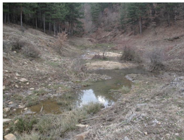
Замочуряване пред входа на водостока, поради затлачване /2015 г./
