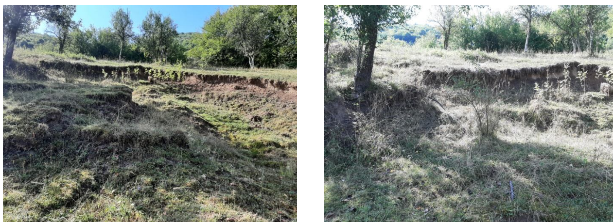
Главен свлачищен откос
