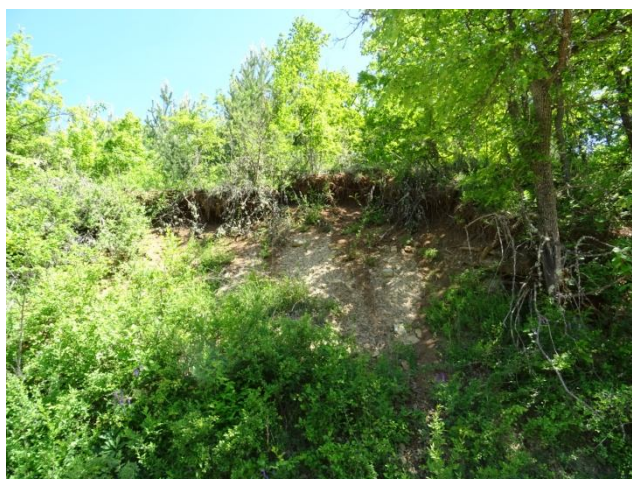
Главен свлачищен откос
