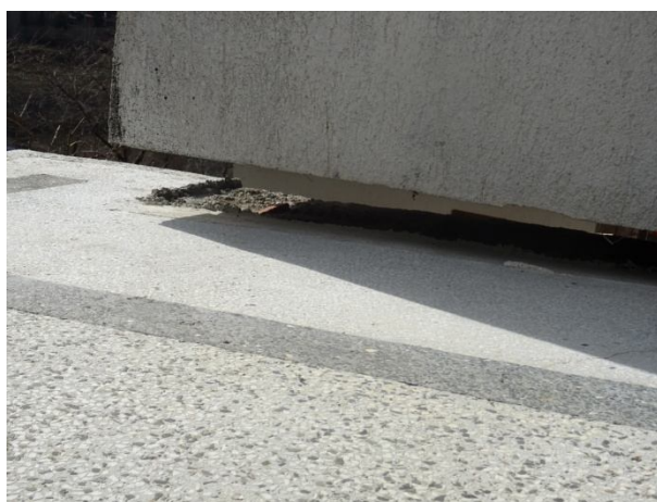
Значими деформации по пристройката на СО1
