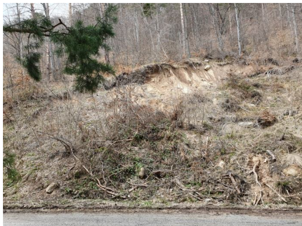
Активно състояние на свлачищен участък при km 29 +050 /април, 2020 г./
