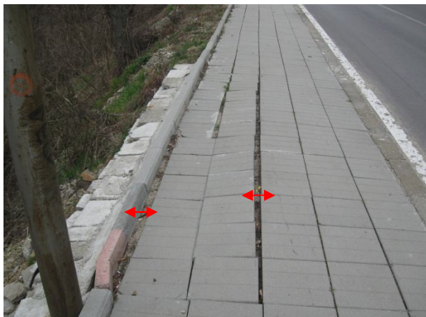
Слягания по тротоар откъм откоса на р. Бистрица с изпълнени дървени пилоти /2015/
