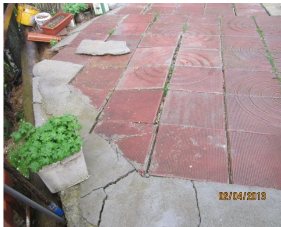
Деформирана външна бетонова площадка и плочник
