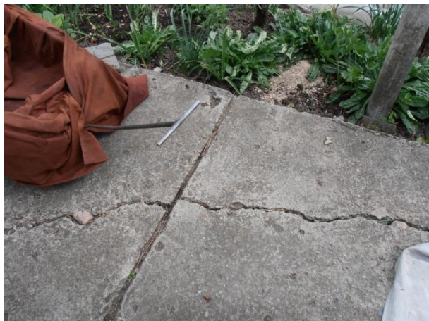
Деформации по външна мазилка и плочници /април, 2015 г./
