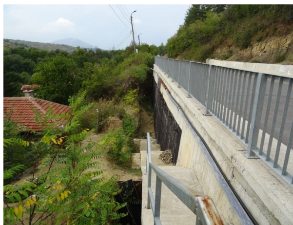
Изградена укрепителна стоманобетонoва анкерирана подпорна стена
