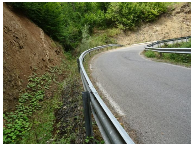
Затлачена канавка, която не е облицована по цялата дължина
