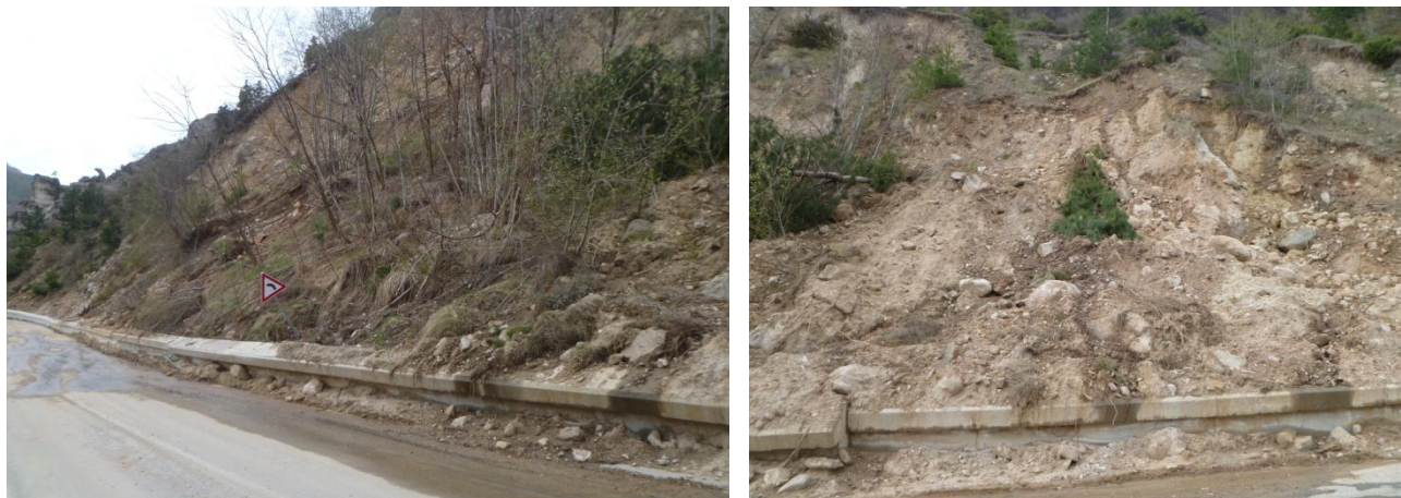
Общ изглед на свлачищния участък /2015 г./
