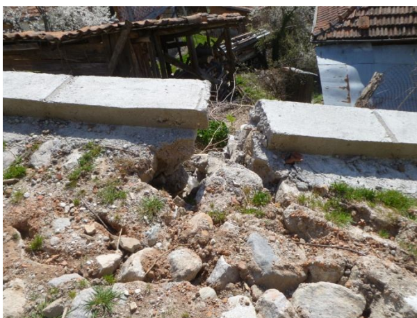
Разрушена каменно-зидана подпорна стена /2015 г./
