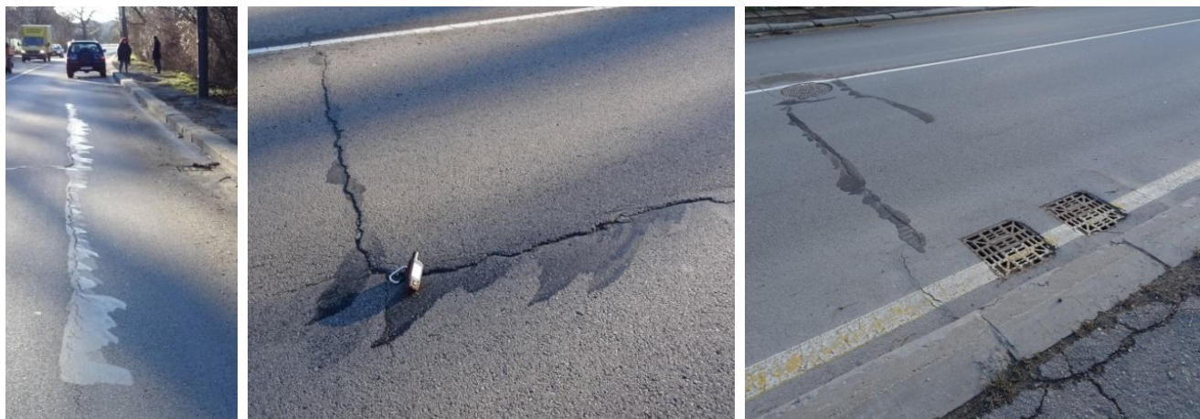
Линейни деформации по уличното платно в североизточния край
