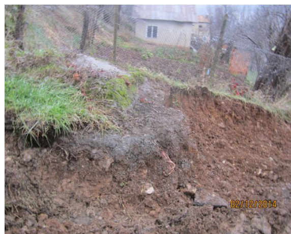
Изглед към стеснения участък от ул. „Виновград“ и извършените изкопни работи за уширяване
