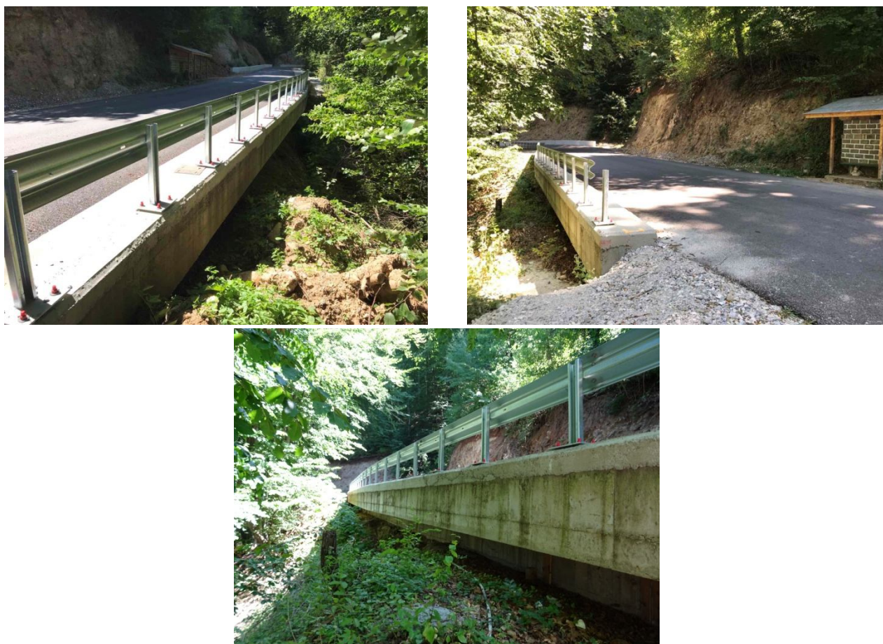
Рехабилитиран и укрепен свлачищен участък на път III-861 при km 6 +350
