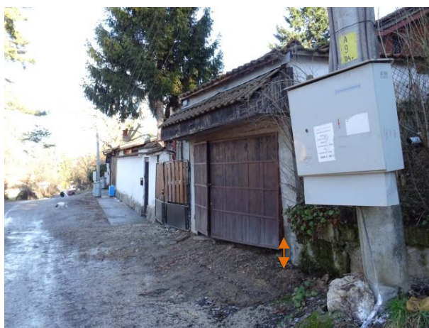
Слягане и подуване между гаража и ел. стълб при № 50
