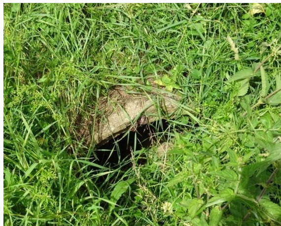
Липса на отводнителна канавка и съществуващ тръбен водосток
