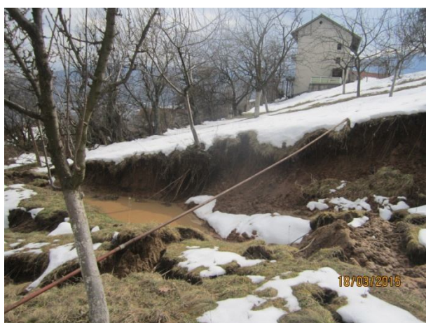
Външно изнесен водопровод /март, 2015 г./
