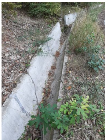
Крайпътна бетонова канавка, на места затлачена
