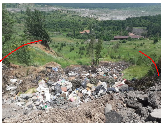
Общ изглед на свлачищния участък
