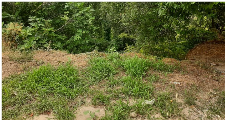
Главен свлачищен откос
