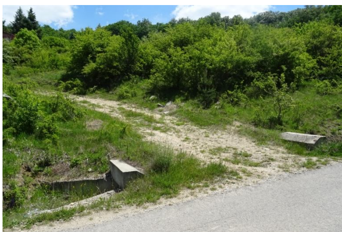
Водосток под коларския път
