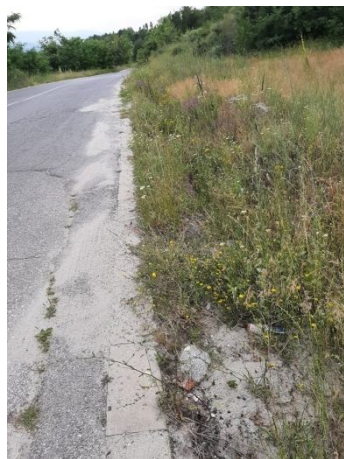
Затлачена и непочистена земна отводнителна канавка
