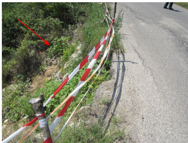
Участък с частично разрушен банкет и откос
