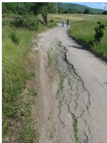
Изглед към участъка с проявени деформации на асфалтовата настилка /2015 г./
