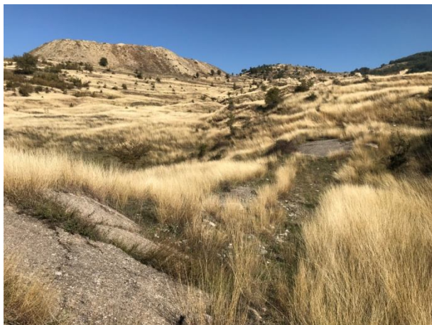
Табан-насипище и оврагообразуване по южния му откос /октомври, 2020 г./
