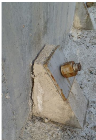
Деформации по фуга и анкер на стената
