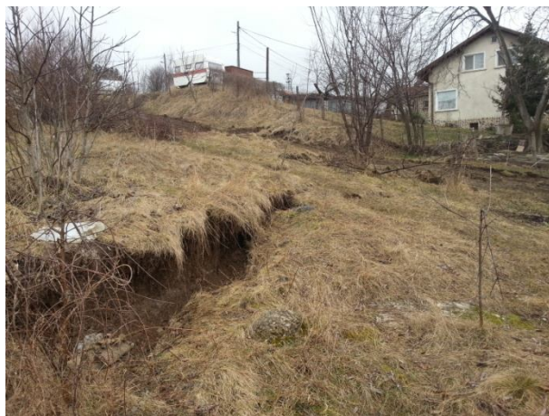
Главен свлачищен откос в близост до имота на ул. „Окол” № 57 /февруари, 2018 г./
