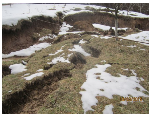
Външно изнесен водопровод /март, 2015 г./
