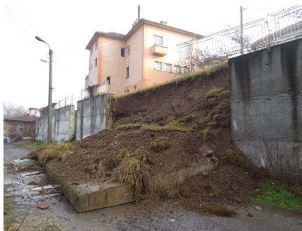
Разрушена подпорна стена
