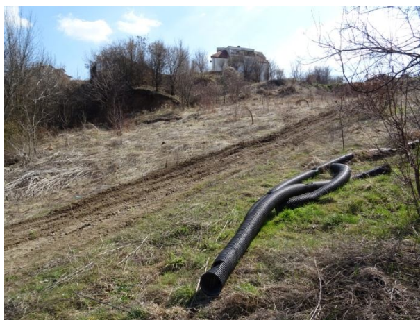
Част от извадена тръба от западното дренажно ребро
