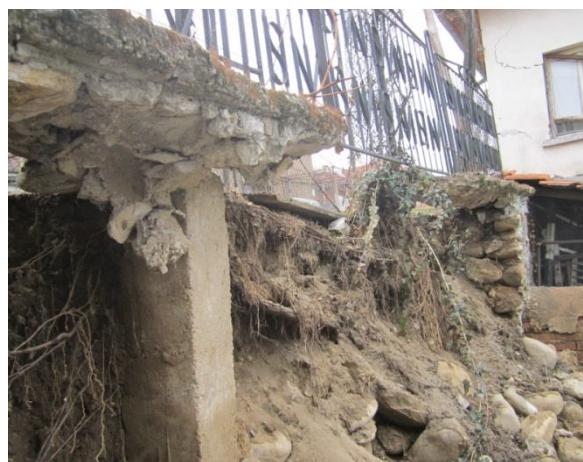
Разрушен подпорен зид /2012 г./
