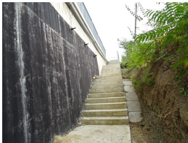
Бетонови стълби и площадки към УПИ ХХІІІ-269
