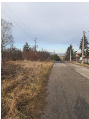
Улично платно в непосредствена близост до свлачищния откос
